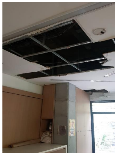
Ilustración 1 cielo falso cocineta primer nivel
