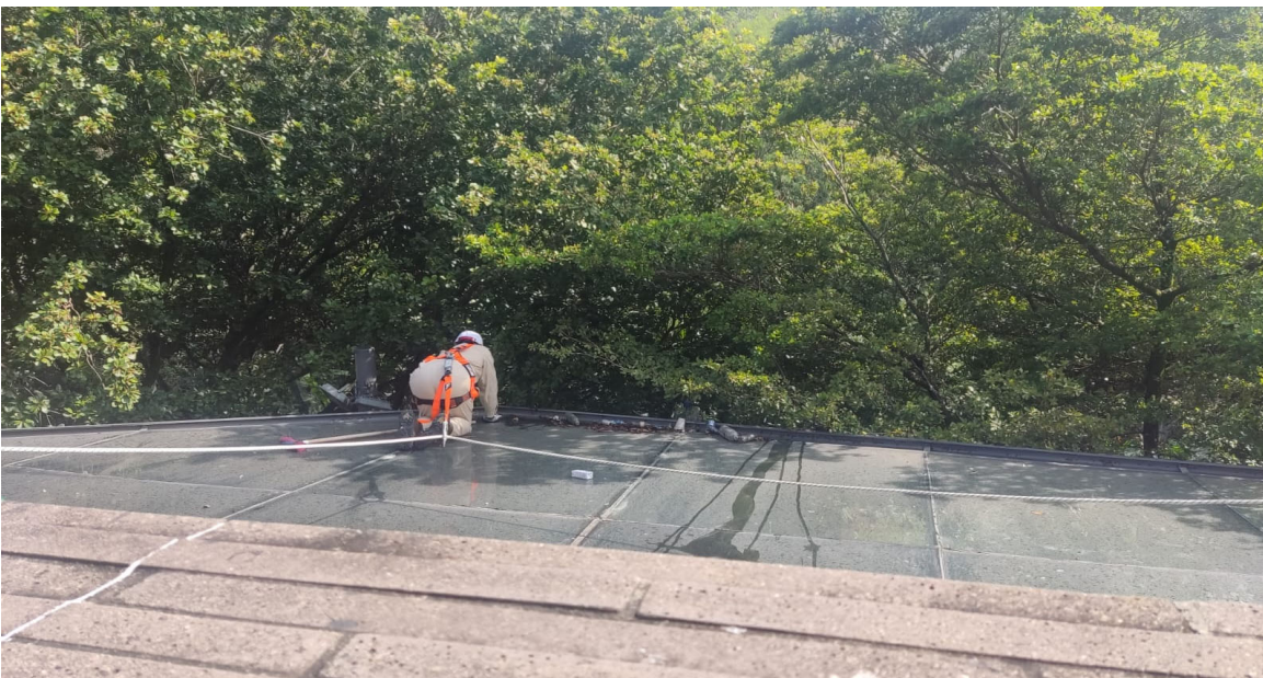
Ilustración N°11 Mantenimiento: Lavado de pérgolas del MCM
