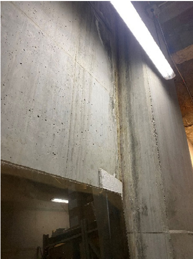
Ilustración N°9 humedades bodegas MCM
