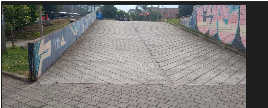
Ilustración N°12 Rampa parqueadero MCM
