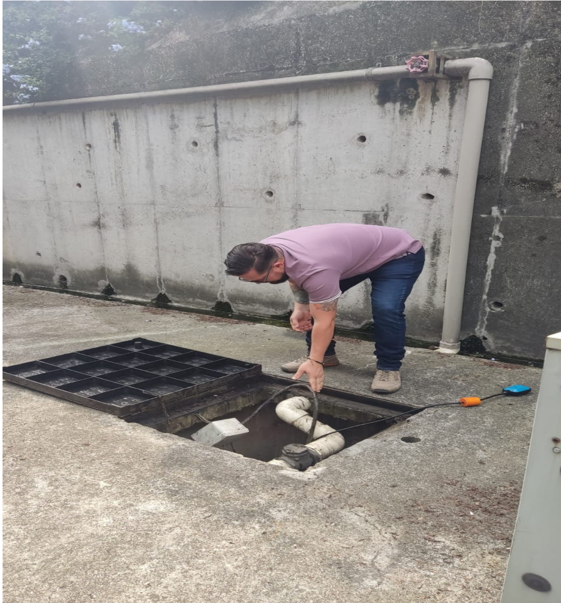
Ilustración N°22 Inspección aguas residuales
