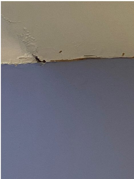
Ilustración N°2 Humedades sala 3, oficina juntas, cocineta, vías de acceso y 3 Piso MCM.
