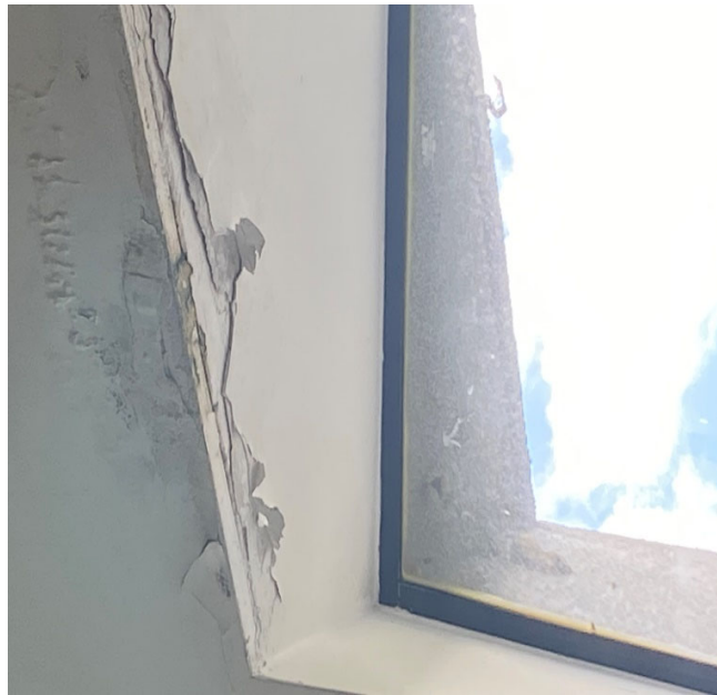
Ilustración N°2 Humedades sala 3, oficina juntas, cocineta, vías de acceso y 3 Piso MCM.
