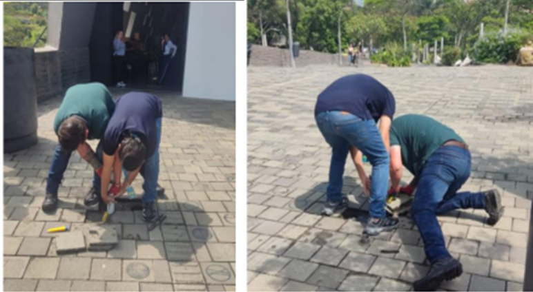
Acompañamiento en el sellamiento tubo de drenaje rampa acceso ingreso principal por filtraciones en sala
